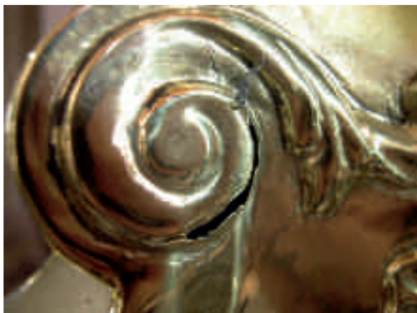
Schade door spanningscorrosie
